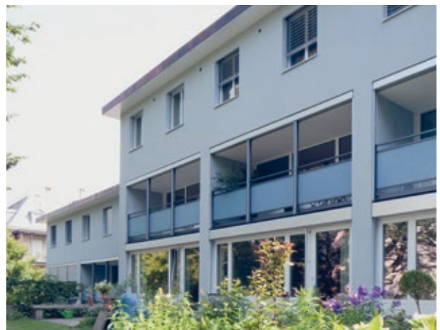
Abbildung 1: Um den Wert eines Gebäudes zu erhalten, ist eine periodische Instandsetzung notwendig. Dabei lohnt es sich auch, energetische Massnahmen zu prüfen. (Fotos: Susanne Völlm, Nina Mann)
