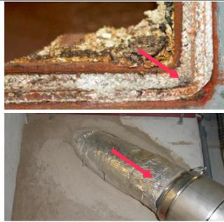
Asbesthaltige Leichtbauplatten an Rohrdeckeln, unter Rohrmanschetten/Muffen, an Brennern, Mauerdurchführungen, Rohrsteckverbindungen usw.
