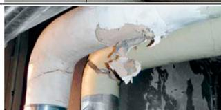
Asbesthaltige Isolationsmaterialien an Heizungslagen, Kesseln, Rohrleitungen und Boilern
