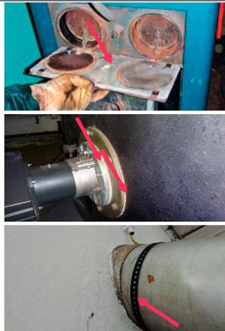
Asbesthaltige Mörtel an Rohrleitungen
