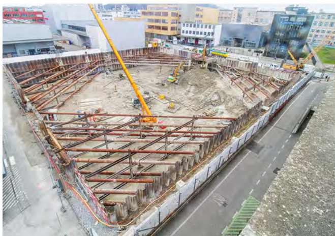
Im Januar 2024 konnten die Bauarbeiten fortgesetzt werden.
