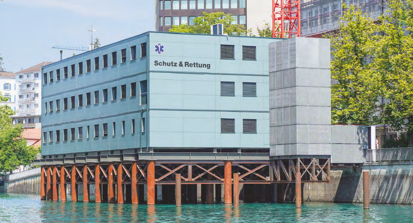
Das Provisorium auf einer Pfahlkonstruktion in der Limmat ist über eine Passerelle mit der Fahrzeughalle verbunden.
