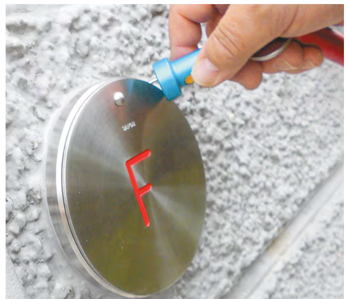
In der Stadt Zürich verfügen rund 2500 Gebäude mit Gefahrenmeldeanlage über spezielle Schlüsselrohre. Diese können von der Feuerwehr mit sogenannten Interventionsschlüsseln geöffnet werden, um den Gebäudeschlüssel zu entnehmen.
