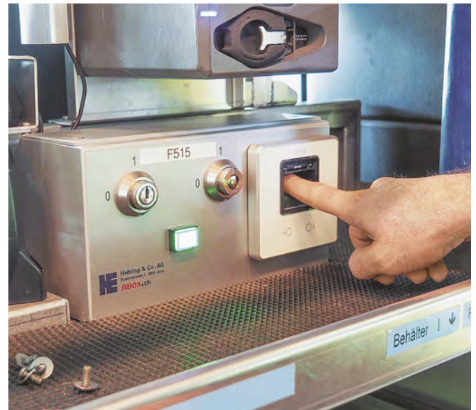
In der Stadt Zürich verfügen rund 2500 Gebäude mit Gefahrenmeldeanlage über spezielle Schlüsselrohre. Diese können von der Feuerwehr mit sogenannten Interventionsschlüsseln geöffnet werden, um den Gebäudeschlüssel zu entnehmen.
