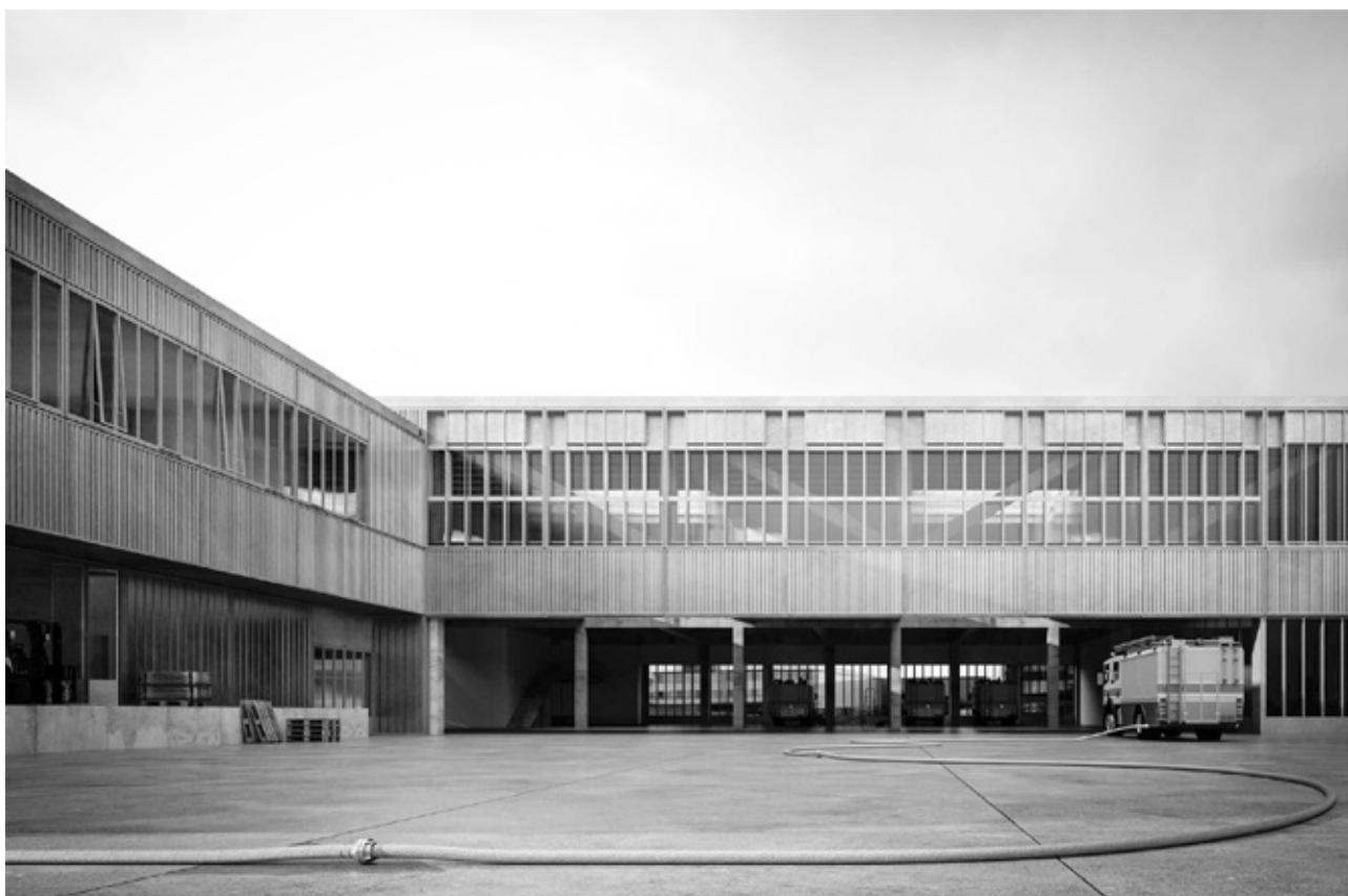
Das Projekt MAZINGA von Enzmann Fischer Partner AG, Zürich, gewann den Architekturwettbewerb für die neue Wache Nord mit ZEL. Hier die Visualisierung des grosszügigen Innenhofs, der auch für die Bereitstellung und Retablierung von Material sowie für Übungszwecke genutzt wird. (Visualisierung © Meyer Dudesek)
