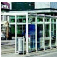
Kleinbauten Boxen, Wetterschütze, Telekommunikation
