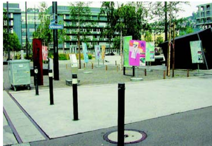
Fehlender Gestaltungsunterhalt auf dem Turbinenplatz
