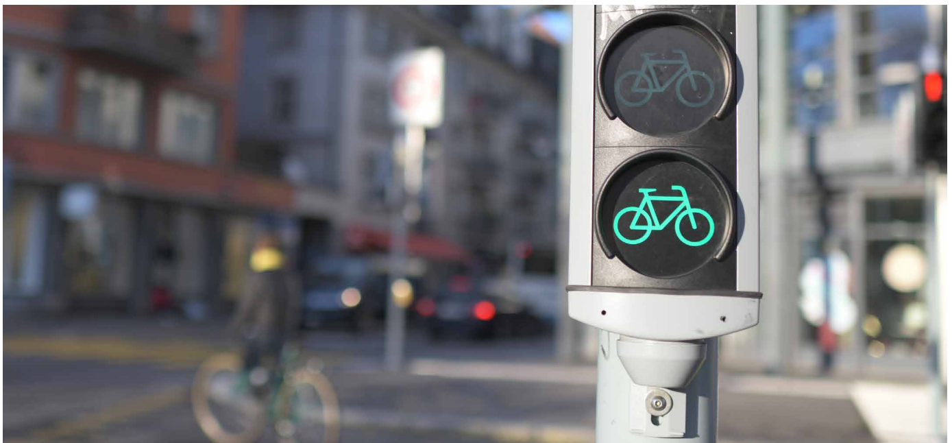
Veloampel an der Langstrasse. Foto: Stadt Zürich, Tiefbauamt
