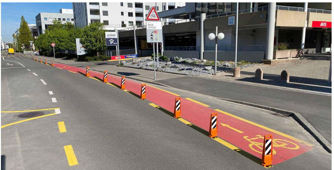
Pilotversuch «Geschützte Velostreifen» vom Frühjahr bis Sommer 2022 an der Baslerstrasse. Foto: Stadt Zürich, Dienstabteilung Verkehr
