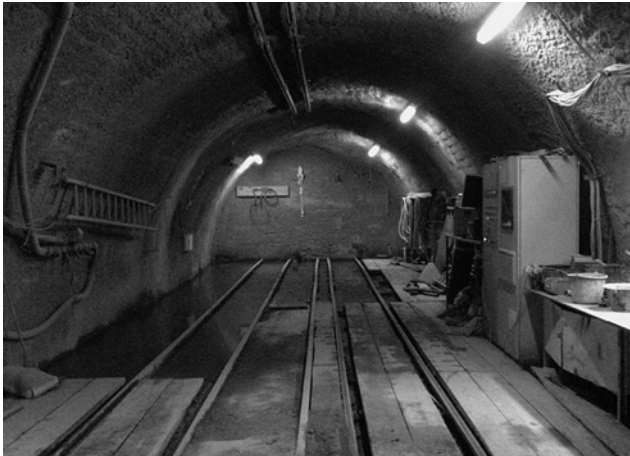
Blick in die Baustelle Uetlibergstollen (Bild: Wasserversorgung)
