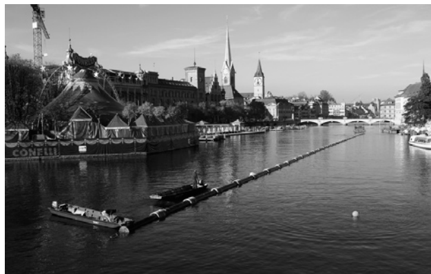
Energiedienstleistungen: Seewasserleitung für die Energieversorgung Fraumünster vor der Verankerung auf dem Grund. (Bild: ewz)
