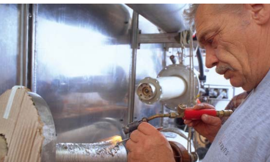
Montagearbeiten an einer Hochspannungsmuffe.
