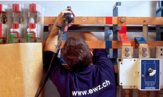
Montagearbeiten an einer Niederspannungsverteilung.
