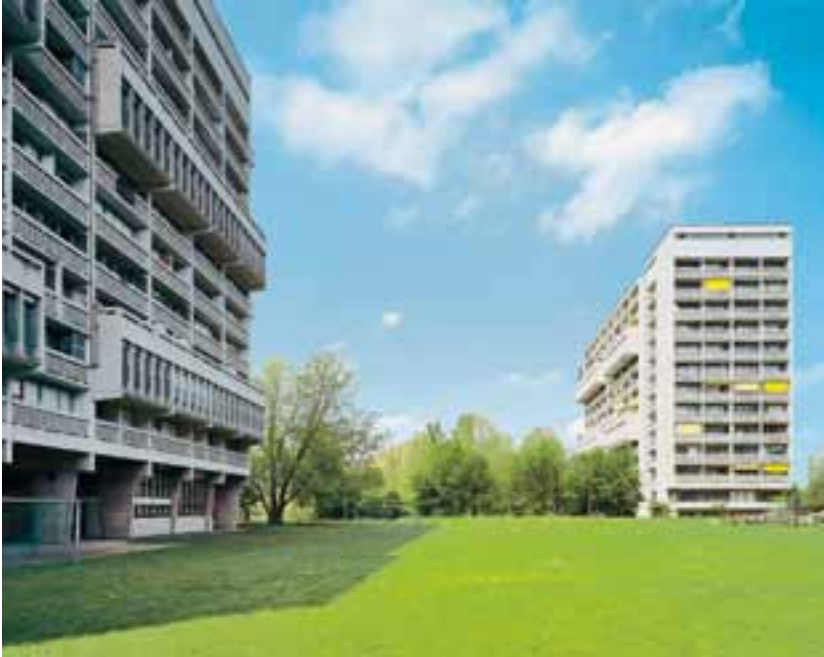
Unteraffoltern II, Betriebsoptimierung Heizanlage
