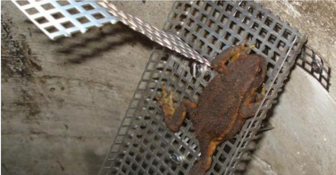
Abb. 21 Die Tiere nutzen die installierte Amphibienleiter im Strassenschacht. In Schächten ohne Amphibienleiter verhungern die Tiere.
