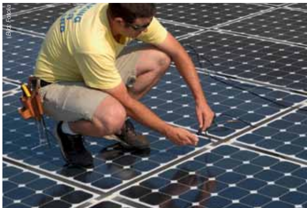
Wachstumsbranche Sonnenenergie: Montage einer Fotovoltaikanlage.
