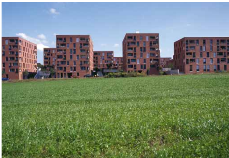
Wohnbauten Allgemeine Baugenossenschaft Zürich, Nettie-Sutro-Strasse
