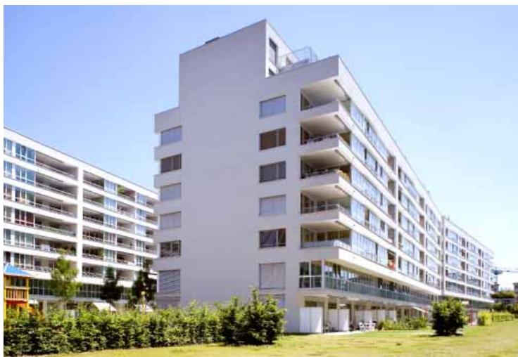
Wohnbauten CeCe-Areal, Wehntalerstrasse
