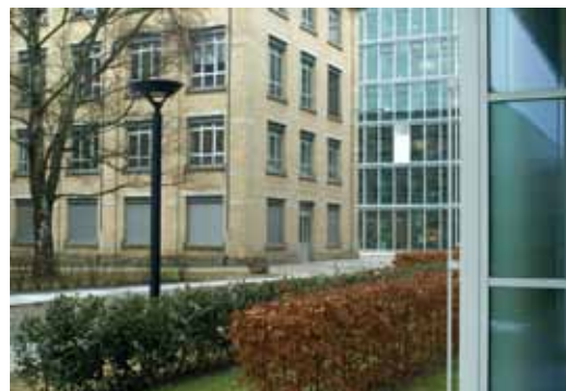
Neu- und Altbauten im Baufeld D
