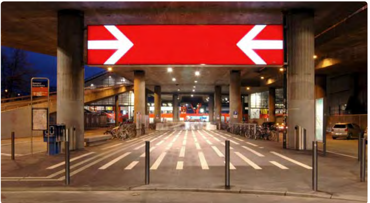
Der aufgewertete Bahnhof Hardbrücke mit dem neuen grosszügigen Zugang
