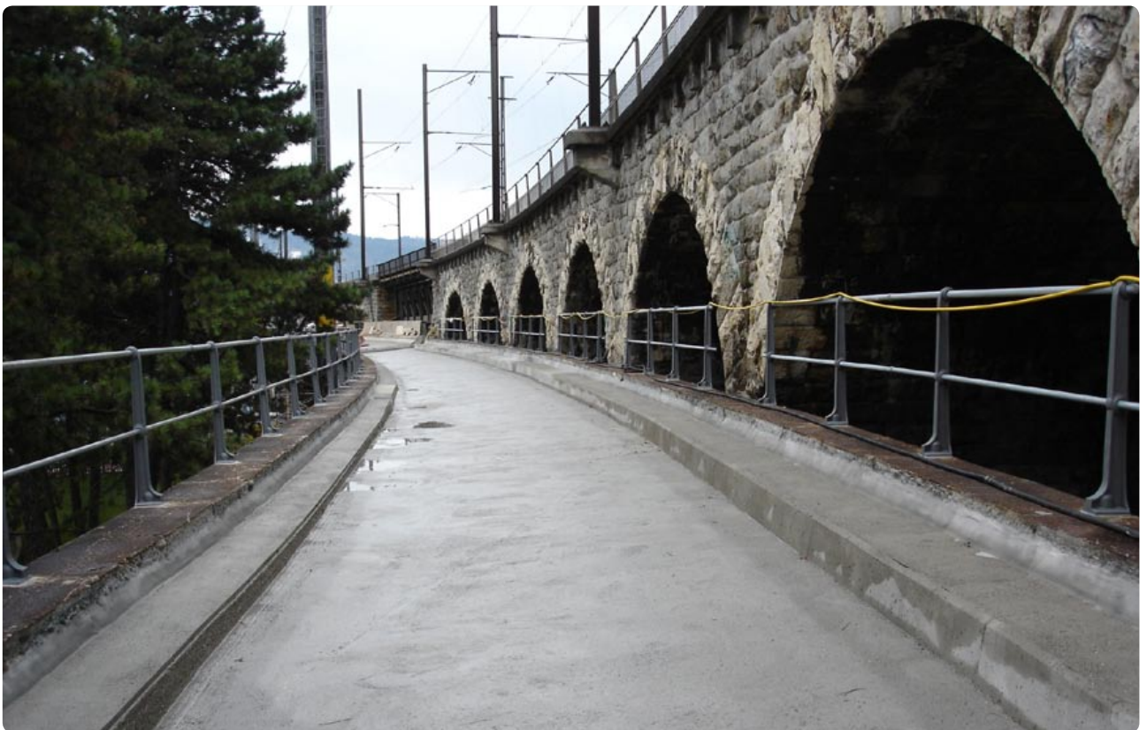
Der Fuss- und Radweg auf dem Lettenviadukt
