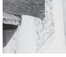
Ortbeton und Flusskiesel
