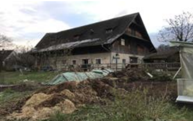
Ansicht Nordwest und Südwest
