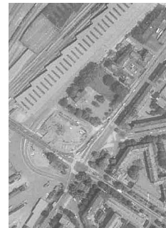
1982 zeigen die Aufnahmen die Auswirkungen des Rampenbaus von 1982 am Hartplatz und die Beschneidung der Schulparzelle auf die heutige Ausdehnung. Der umgebende Grüngrün ist nur noch fragmentarisch erhalten. Die städtebauliche Randlage präsentiert sich bereits dazumal. Die Anbindung an das Gefüge innerhalb des Quartiers war gegeben.
