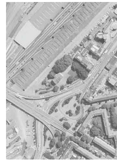
1976 liess sich die flächige Ausgewogenheit zwischen Platz und Vegetation gut erkennen. Die in die Jahre gekommene Begrünung lässt den grünen Rahmen lückig erscheinen. Die Baumreihe wurde durchlässiger.
