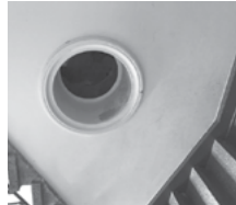
Referenz runder Fenster im Treppenhaus
