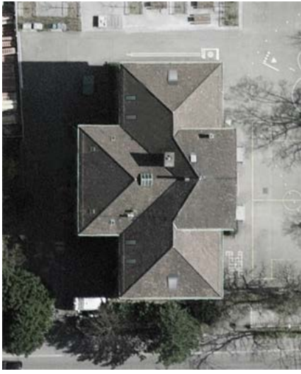
Schulhaus Nordstrasse, Dachauschnitt Zwei unterschiedliche Typen Dachflächenfenster betreiben die ausgebauten Dachräume Ost und West
