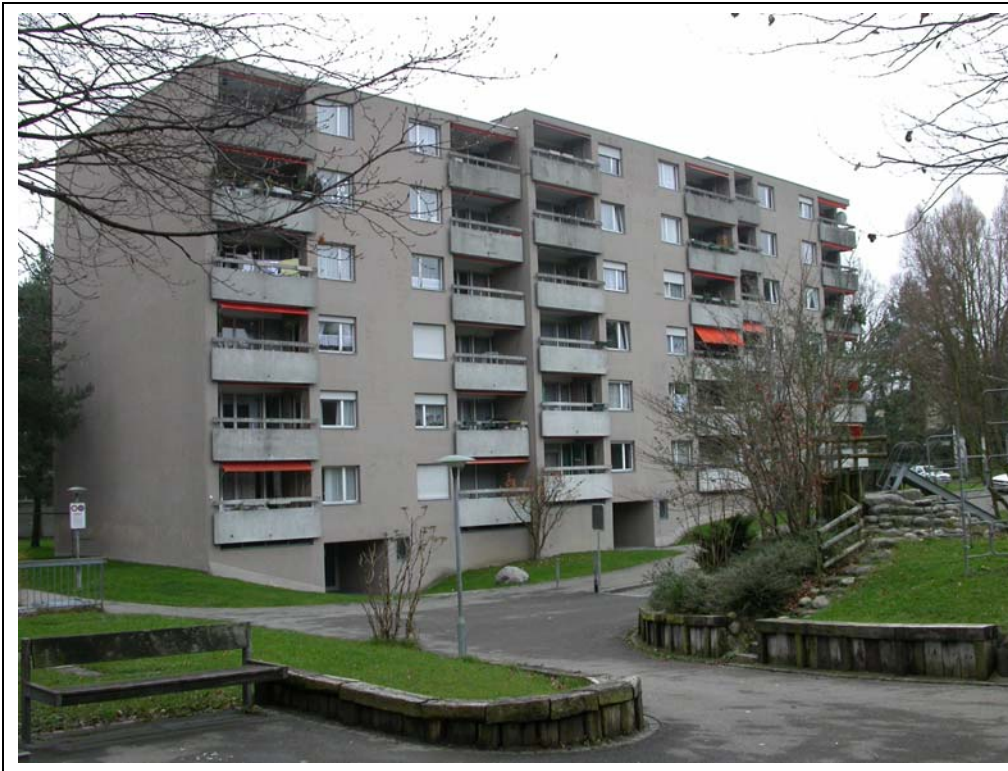
Abb. A2.3: Objekt Heumatt Langhaus
