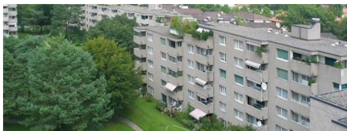
Abbildung 2 Aussenraum der unsanierten Wohnblöcke
