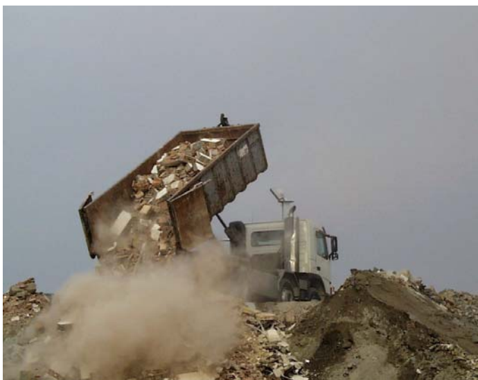
Bild 1: Eine vermehrte Abbruchtätigkeit ist die Ursache für die steigende Zunahme an Bauabfällen.
