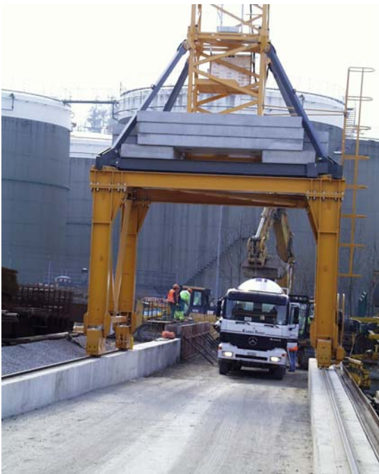
Bild 3: Erstellen einer Kranbahn mit Beton aus Mischabbruchgranulat.
