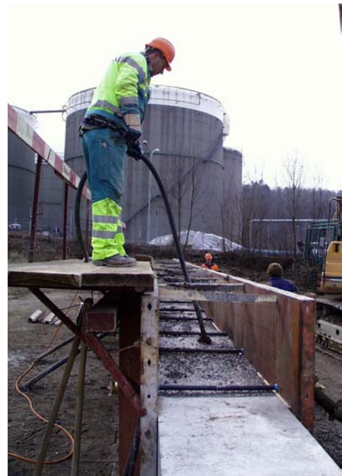
Bild 4: Verdichtungsarbeiten
