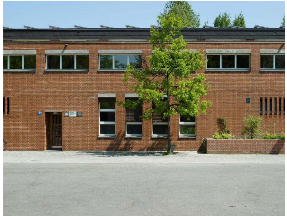
Denkmalgeschütztes Schulhaus Auhof. Solarstromanlage auf extensiv begrünem Flachdach. Dach wurde privatem Contractor zur Verfügung gestellt, der Strom in ewz Solarstrombörse einspeist.
