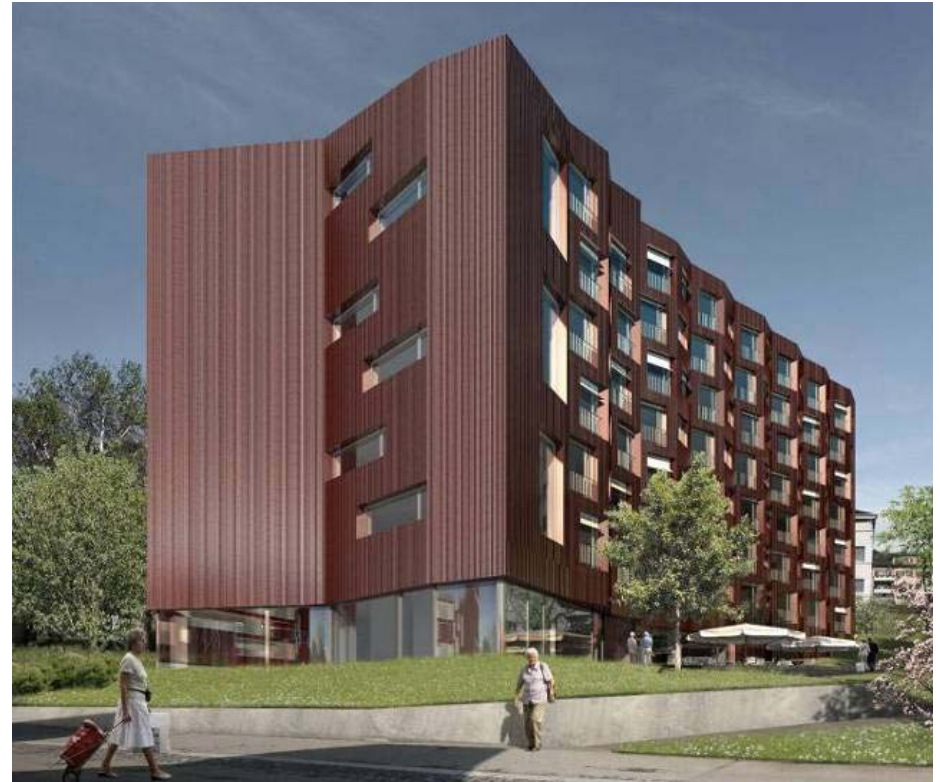
Ersatzneubau Altersheim Trotte, 2009 mit provisorischem Zertifikat MINERGIE-P-ECO ausgezeichnet.
