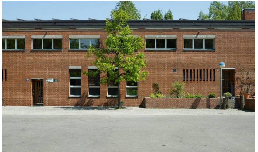
Abbildung 11: Denkmalgeschütztes Schulhaus Auhof mit Solarstromanlage auf extensiv begrüntem Flachdach. Die Stadt hat dieses Dach einem privaten Contractor zur Verfügung gestellt, der den Strom in ewz Solarstrombörse einspeist.
