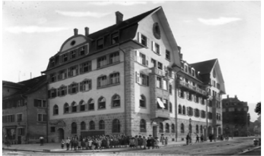
Abbildung 5: Instandsetzung Kreisgebäude 3. Der denkmalgeschützte Bau (im Bild das ursprüngliche Erscheinungsbild) erreicht den Standard für MINERGIE-Modernisierungen.
