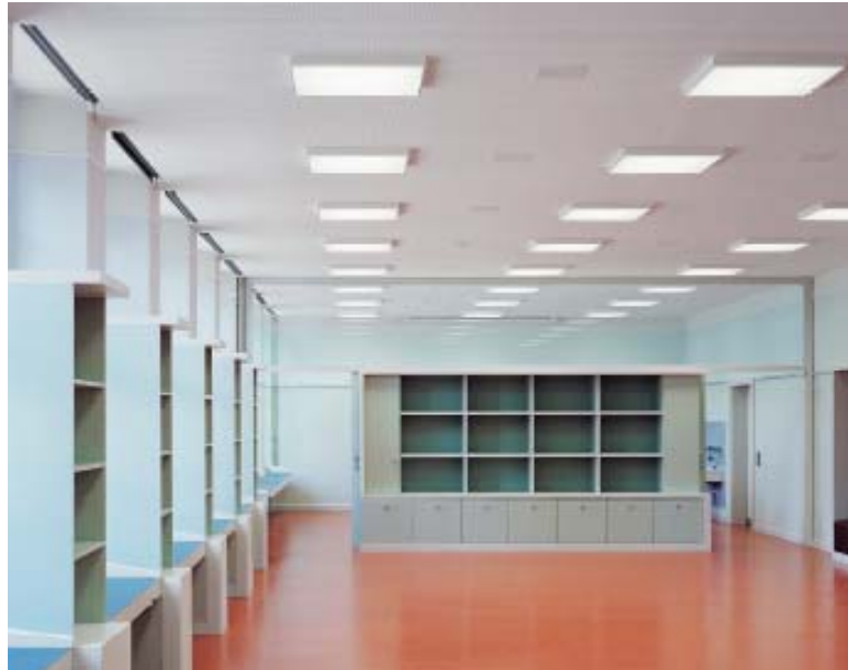
Abbildung 8: Instandsetzung und Umbau Schulanlage Milchbuck. Anforderung MINERGIE-Beleuchtung erreicht, MINERGIE-Modul Leuchten eingesetzt.
