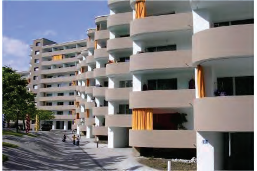
Abbildung 27: Gesamtinstandsetzung der städtische Wohnsiedlung Heuried, an der nach Inbetriebnahme eine Energieanalyse durchgeführt wurde
