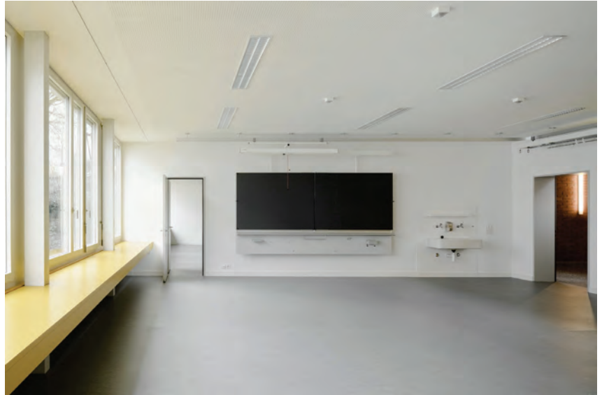
Abbildung 9: Instandsetzung und Umbau Schulanlage Dölttschi. Anforderung MINERGIE-Beleuchtung erreicht, MINERGIE-Modul Leuchten eingesetzt.
