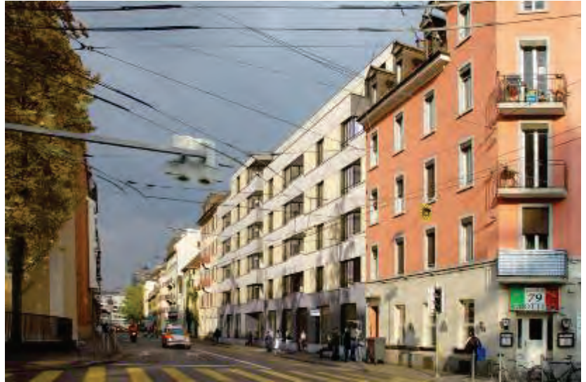
Abbildung 2: Alterswohnungen Feldstrasse, Stiftung für Alterswohnungen der Stadt Zürich SAW, welche im Jahr 2010 mit dem provisorischen Zertifikat MINERGIE-ECO ausgezeichnet wurden.
