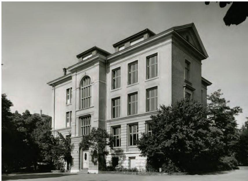
Abbildung 12: Das Schulhaus Weinberg (im Bild der Originalzustand, Baujahr 1891) wird im Rahmen der Instandsetzung mit einer Wärmepumpe ausgerüstet. Dank der Massnahmen an Gebäudehülle und Wärmeverteilung wird die maximale Vorlauftemperatur auf 40°C reduziert.
