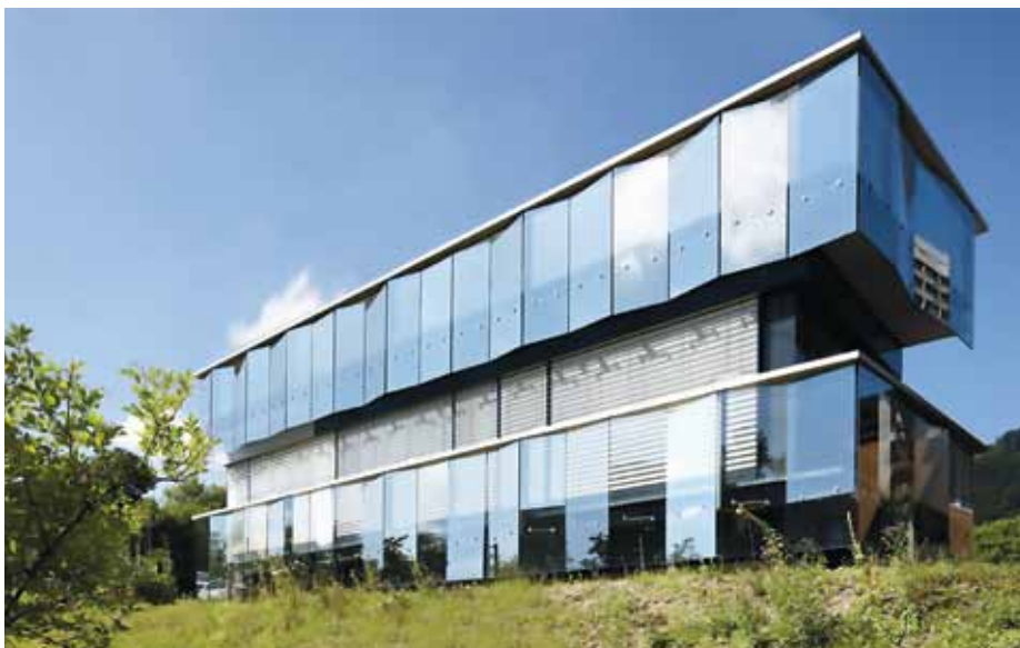
Das P+D-Objekt mit innenliegenden Zweierzimmern und vollständig erstellter Aussenfassade inklusive Serviceschicht.
