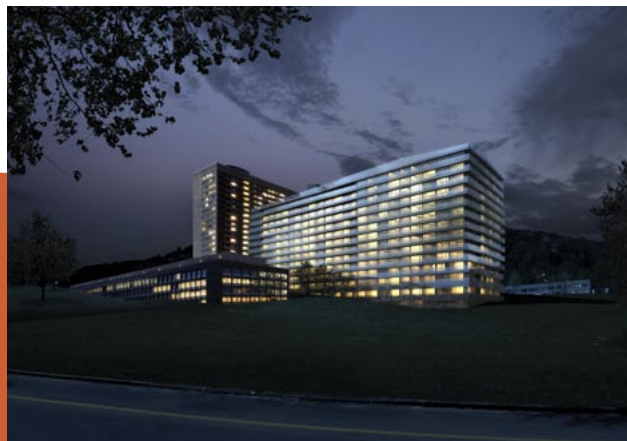
2012: Das ehemalige Bettenhaus wird durch das neue abgelöst.
