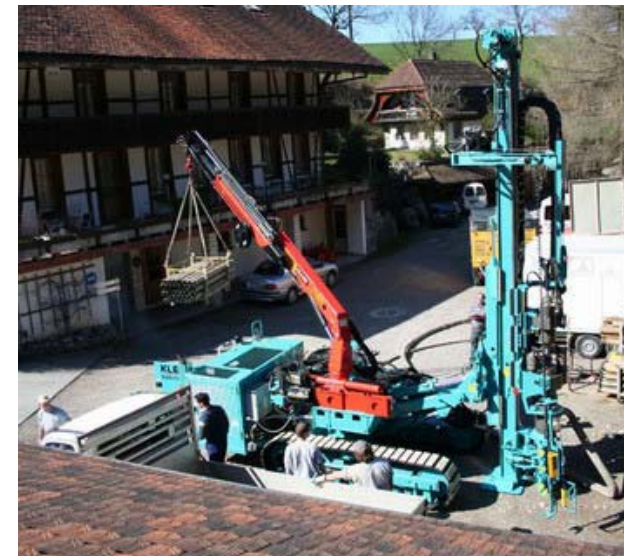
Erdsondenbohrung
