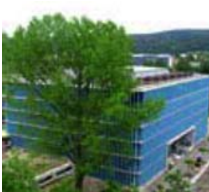
Verwaltungsbau Forum Chriesbach Dübendorf
