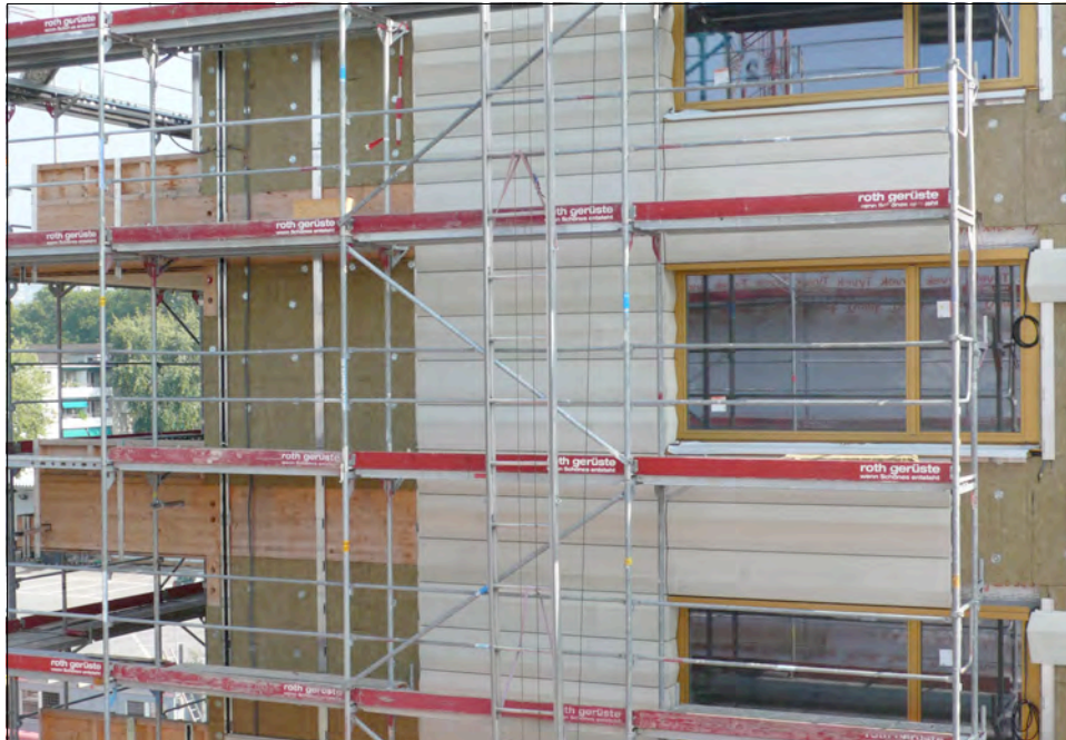
Massivholzbau, beidseitig wärmedämmt, hinterlüftet Platten auf Faserbeton... Wohn- und Gewerbeliegenschaft in Zürich-Albisriederplatz der BGZ, Pool-Architekten, 8003 Zürich
