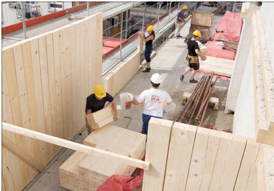
Massivholzbau, Zapfenverbindungen, einfaches System auch für Kleinbetrieb mit Wertschöpfung vor Ort Wohn- und Gewerbeliegenschaft in Zürich-Albisriederplatz der BGZ, Pool-Architekten, 8003 Zürich
