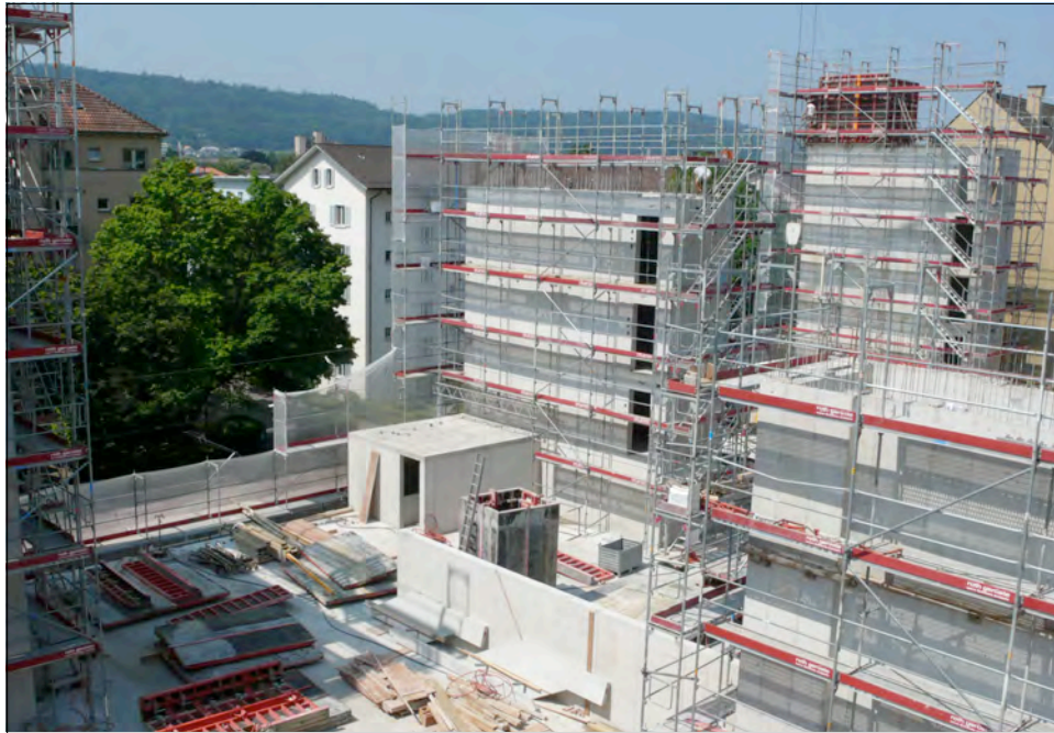
Betonierte Treppenhaukerne... Wohn- und Gewerbeliegenschaft in Zürich-Albisriederplatz der BGZ, Pool-Architekten, 8003 Zürich
