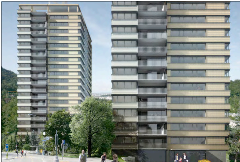
Wohn- und Essraumerweiterung durch Küchenanbauten, Erhöhung der Kompaktheit, Aussendämmung mit hinterlüfteter Verkleidung, Graue Energie 64 MJ/m 2 a, Heizwärmebedarf Q h 65 MJ/m 2 a, bestehende Gasheizung? Hochhausanierung Sihlweid in Zürich-Leimbach der BGZ, Architekten Harder Haas Partner AG, 8193 Eglisau
