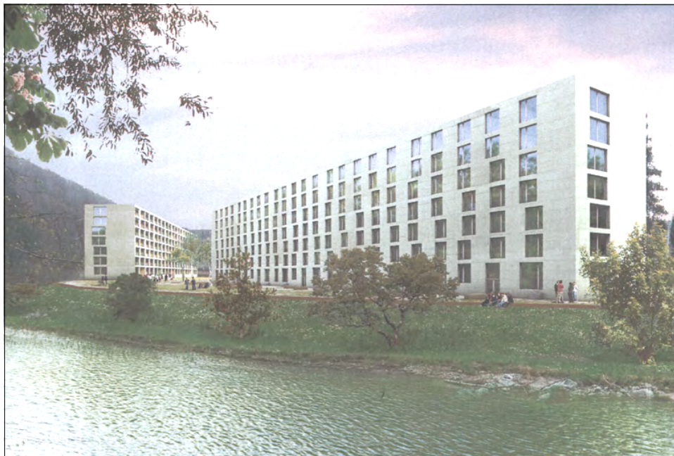
Sehr kompakt, Balkonschicht vorangestellt, Mischbauweise, Graue Energie 103 MJ/m 2 a, Heizwärmebedarf Q h 54 MJ/m 2 a, Holzheizung, WP für Warmwasser im Sommer, PV-Anlage, Anreize reduzierte Mobilität... Wohn- und Gewerbeliegenschaft in der BGZ in Zürich-Leimbach, Architekturbüro Dachler Partner, 8003 Zürich,
