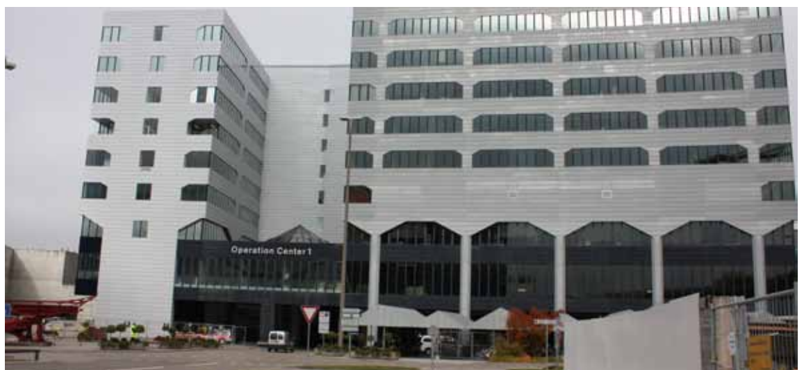
Abb. 3: Im Flughafen Zürich wurden die ehemaligen Räumlichkeiten von Skyguide als passende Umgebung für die neue Einsatzleitzentrale angesehen (Foto: Schutz & Rettung Zürich)
