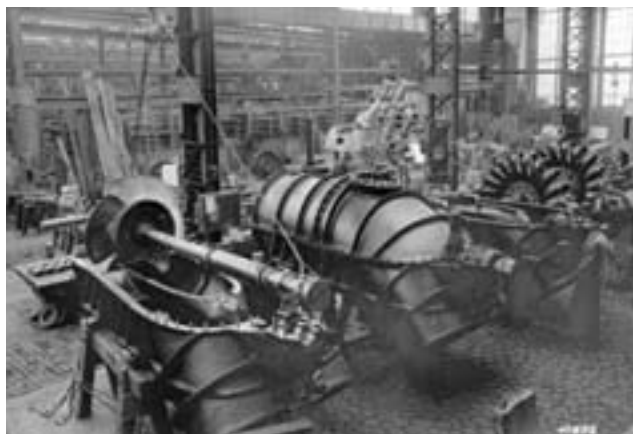
Aus dem Bildarchiv der Firma Escher Wyss: drei Pumpen für Wasserturbinenwerke in der Fabrikationshalle der Escher Wyss. (Bild: Stadtarchiv)
