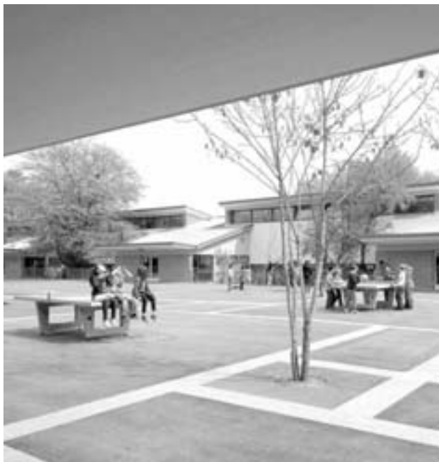
Ausgezeichnet: Furaldächer im Schulhaus Untermoos, instandgesetzt von Diethelm Spillmann Architekten. (Bild: Roger Frei)
