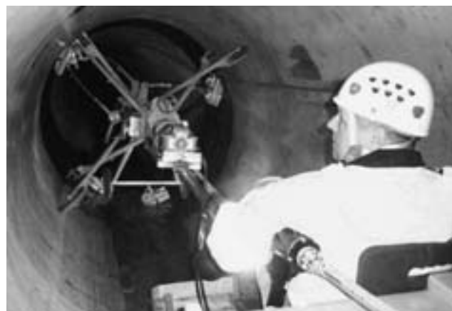
Maschineneinsatz für die Stollenreinigung.
