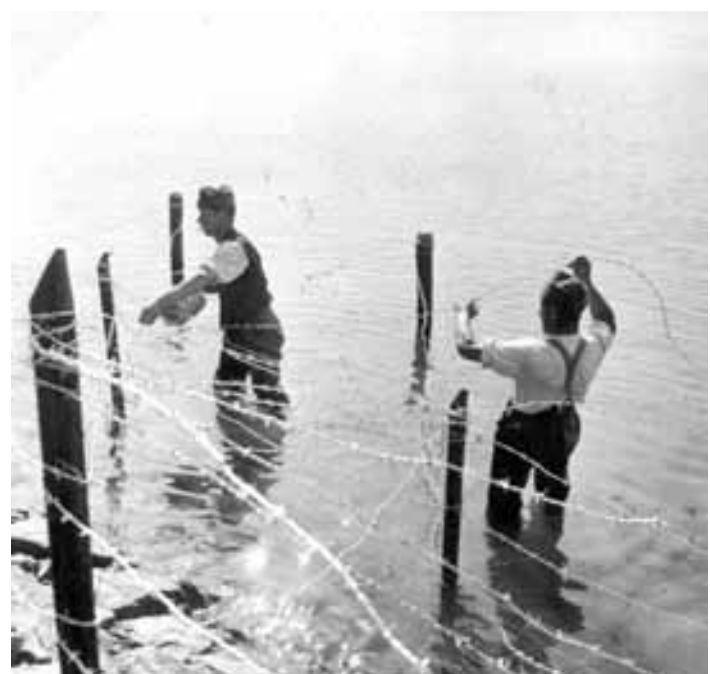
Hindernisbauten am linken Seeufer während des 2. Weltkriegs (VII. 76. Stadtrat Erwin Stirnemann, Nachlass)
