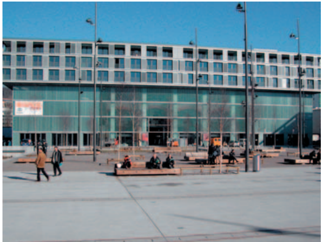
Turbinenplatz mit Ladenzentrum Puls5
