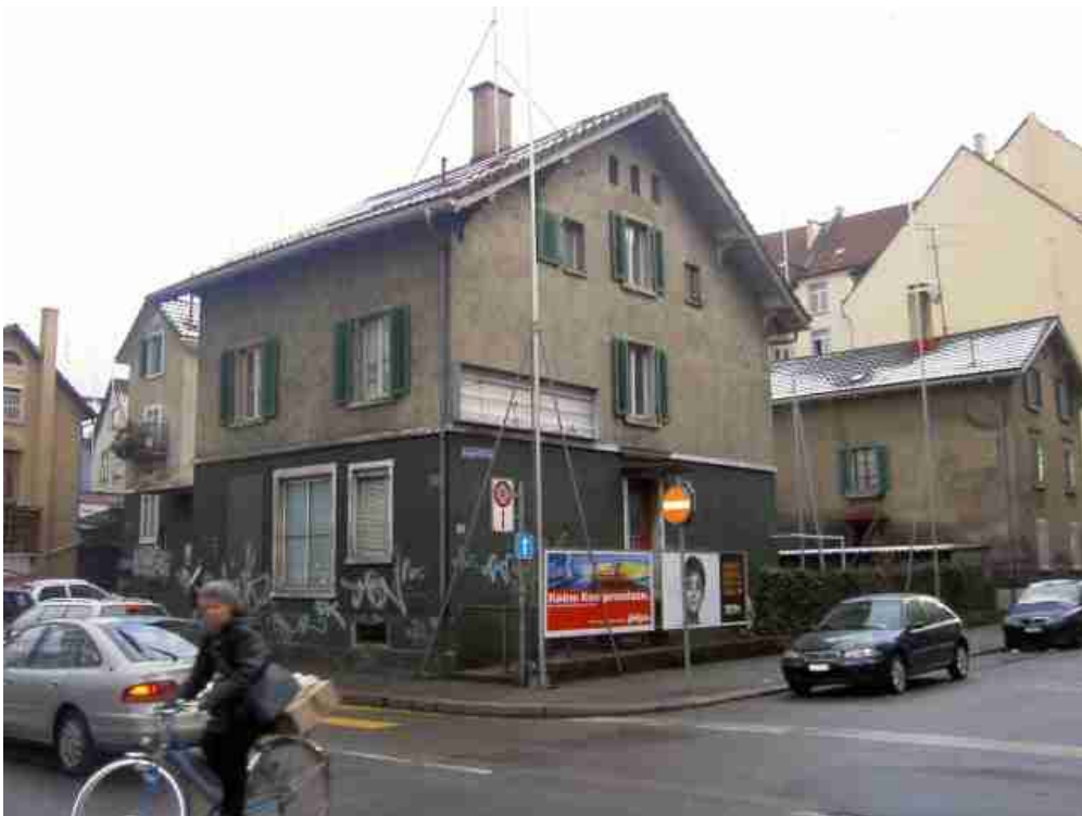
Abb. 22: ausgesteckte Profile an der Weststrasse 101, 105, 107
