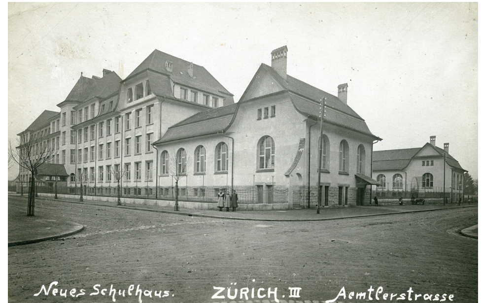
Die Schulanlage Aemter von Architekt Gustav Gull kurz nach der Eröffnung (Bild: BAZ_096420, Friedrich Ruef-Hirt)
