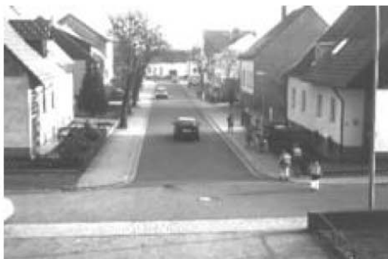
Die Waldstraße vorher
