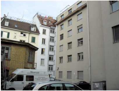
Innenhof der Stauffacherstrasse 101
