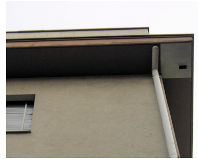
Im Blech wurde eine Einflugöffnung für Alpensegler ausgespart
