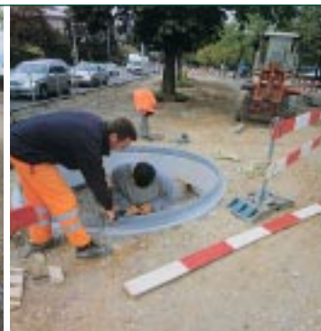
Besondere Aufmerksamkeit galt unter der Leitung von Baumpflegerin Sibylle Trüb dem Wurzelschutz der bestehenden Bäume. Im Platzbereich wurden die Wurzeln mit einer speziellen Kiesmischung überdeckt, im Bereich des asphaltierten Radwegs schützen ringförmige Einfassungen das Wurzelwerk vor Verdichtungen.
