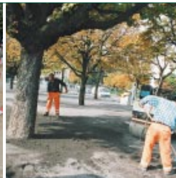
Besondere Aufmerksamkeit galt unter der Leitung von Baumpflegerin Sibylle Trüb dem Wurzelschutz der bestehenden Bäume. Im Platzbereich wurden die Wurzeln mit einer speziellen Kiesmischung überdeckt, im Bereich des asphaltierten Radwegs schützen ringförmige Einfassungen das Wurzelwerk vor Verdichtungen.
