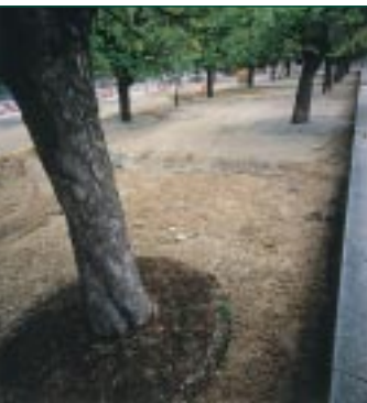
Besondere Aufmerksamkeit galt unter der Leitung von Baumpflegerin Sibylle Trüb dem Wurzelschutz der bestehenden Bäume. Im Platzbereich wurden die Wurzeln mit einer speziellen Kiesmischung überdeckt, im Bereich des asphaltierten Radwegs schützen ringförmige Einfassungen das Wurzelwerk vor Verdichtungen.
