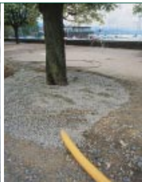
Besondere Aufmerksamkeit galt unter der Leitung von Baumpflegerin Sibylle Trüb dem Wurzelschutz der bestehenden Bäume. Im Platzbereich wurden die Wurzeln mit einer speziellen Kiesmischung überdeckt, im Bereich des asphaltierten Radwegs schützen ringförmige Einfassungen das Wurzelwerk vor Verdichtungen.
