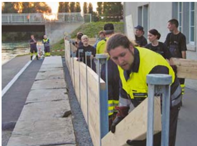
Hochwasserschutz im Test: In nur zwei Stunden stand die Barriere, errichtet von der Freiwilligen Feuerwehr.
