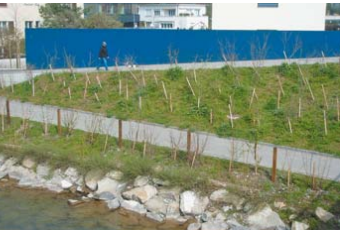
Uferverbauung mit Natursteinen und einem Lebendverbau aus Baumstämmen und ausschlagfähigen Weidenstecklingen.
