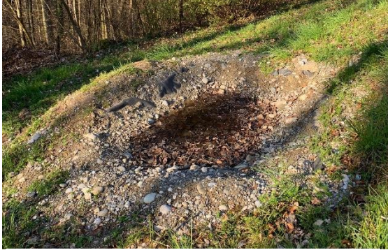
Anlegen eines Tümpels für die Unken
