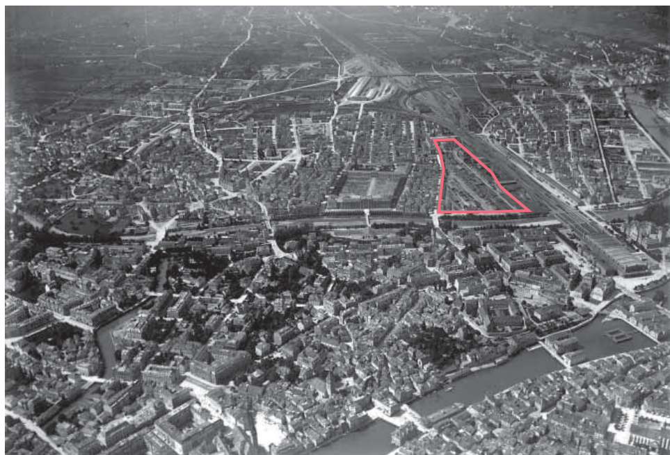
Ballon-Flugbild in Richtung Limmattal von Eduard Spelterini, um 1907. Die historische Strasse von der Sihlporte über die Sihl nach Baden (links, breite weisse Schlangenlinie) sowie der ebenfalls über die Sihl führende Gleisfluss des Hauptbahnhofs (Europaallee rot umrahmt).
