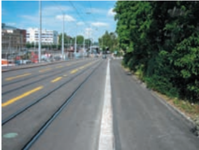
Trottoir Hofwiesenstrasse - An der Fahrbahn anliegendes Trottoir
