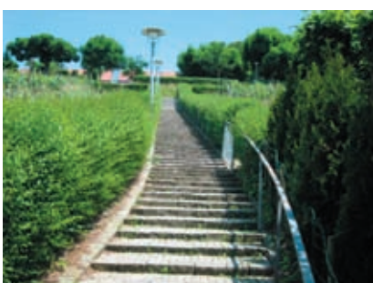
Steig Jupiter-Steig - Treppenweg gepflästert, mit Handlauf aber ohne Schieberampe, abgegrenzt durch Hecken
