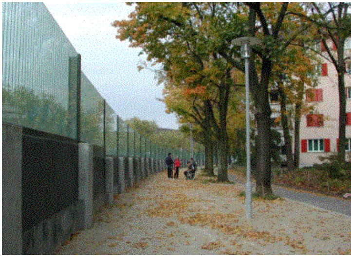
die neue Lärmschutzwand zum Seebahngraben am Urselweg
