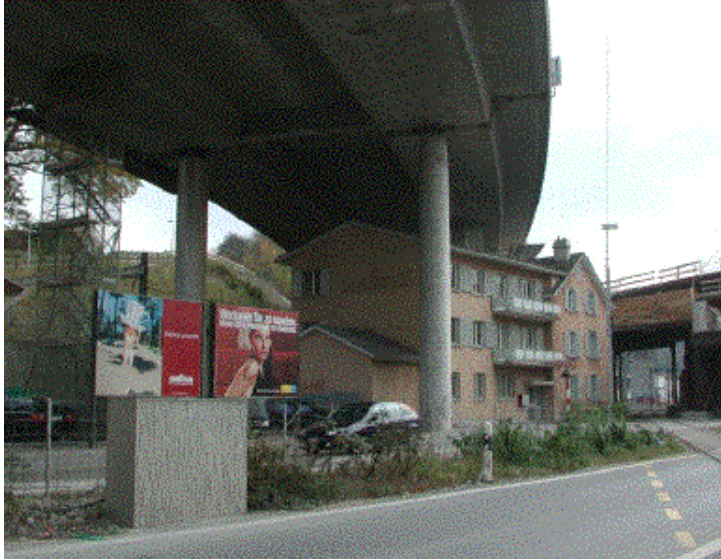
Allmendstr.77: augenfällige Überschneidung von Nationalstrasse mit Bundesbaulinien und bestehender Überbauung an kantonalen Baulinien
