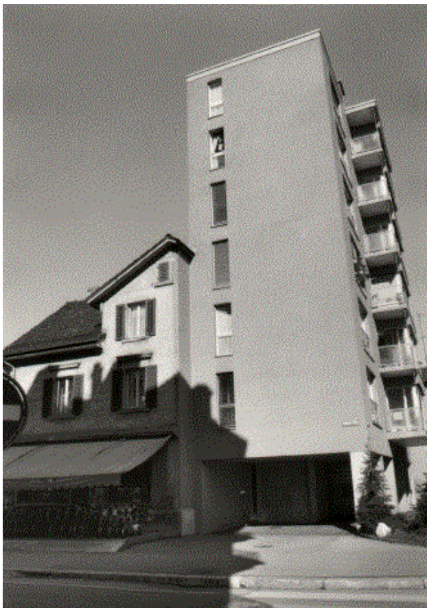
solche städtebaulichen «Wunden» der Nahtstelle Alt-Neu kann auch der leichte Baulinienversatz nicht heilen. (ehem. Situation Ecke Josefstrasse/Ackerstrasse)
