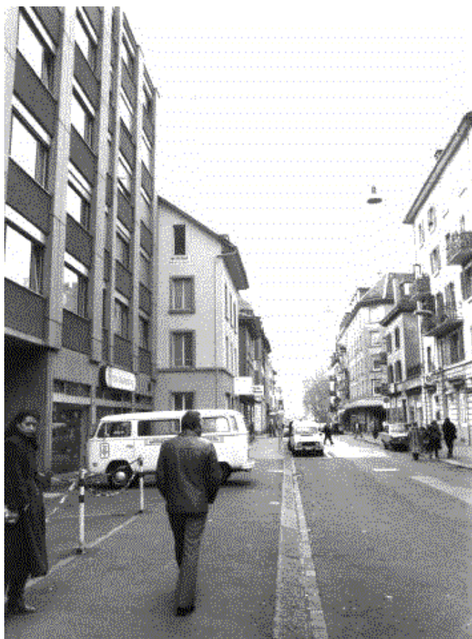
dieser «Neubau» an der Brauerstrasse entstand auf Grund einer nie realisierten «projektierten Baulinie»
