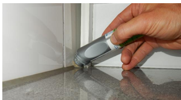
Kombination mehrerer Massnahmen: Mit Silikon abgedichtete Fuge und Anwendung von Silikatstaub mit dem «kiguFLIP». Foto: Stadt Zürich, UGZ
