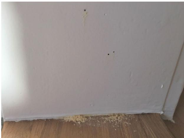
Ausflugslöcher und Bohrmehl des Splintholzkäfers in einem Türrahmen. Das Bohrmehl sammelt sich am Boden. Foto: Stadt Zürich, UGZ
