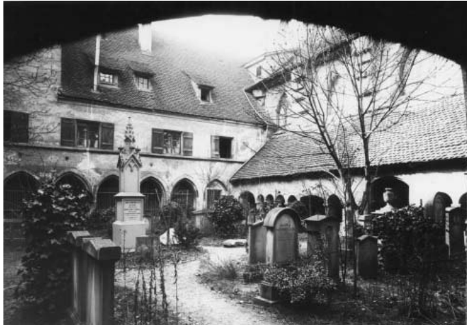
Der alte Kreuzgang vor dem Abbruch.
