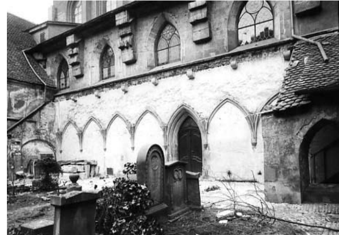
Abbruch des Kreuzgangs. Südwand der Kirche.
