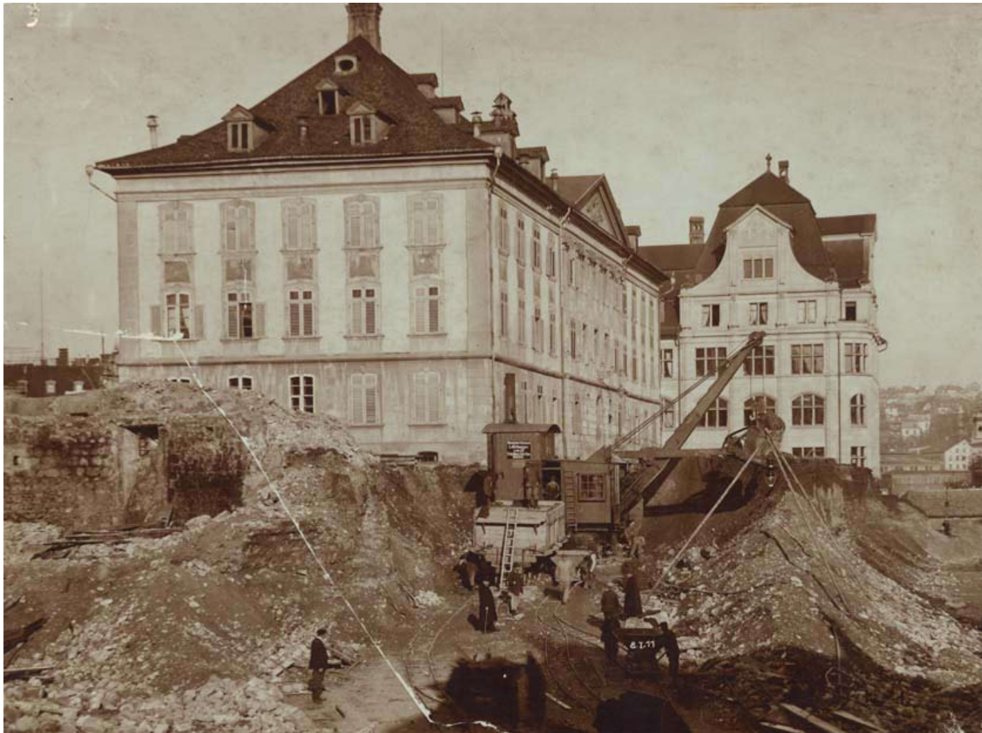
Abtragung des Hügels um das ehemalige Waisenhaus. Foto Januar 1912.
