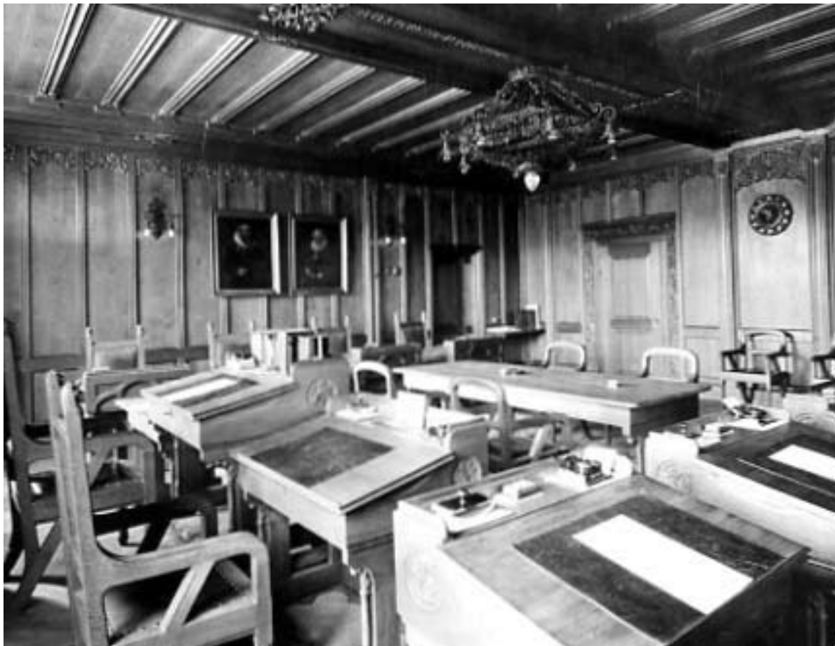
Vertäferter Stadtratssaal im 2. Obergeschoss des Stadthauses. Foto 1902.
