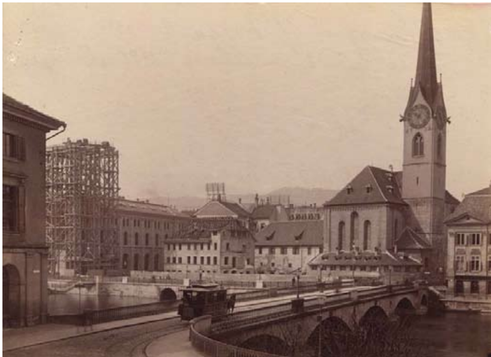
Abbruch der Abteigebäude. Foto von Robert Breitingen, 22. April 1898.
