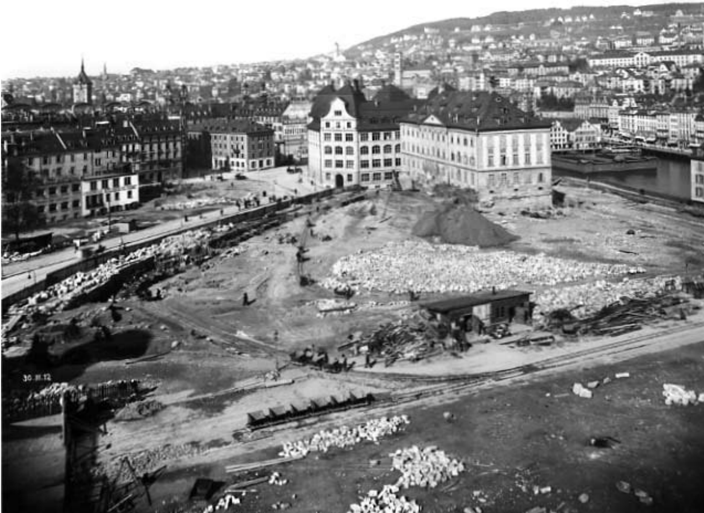
Das Areal nach dem Abbruch der Klostergebäude. Foto 30. März 1912.
