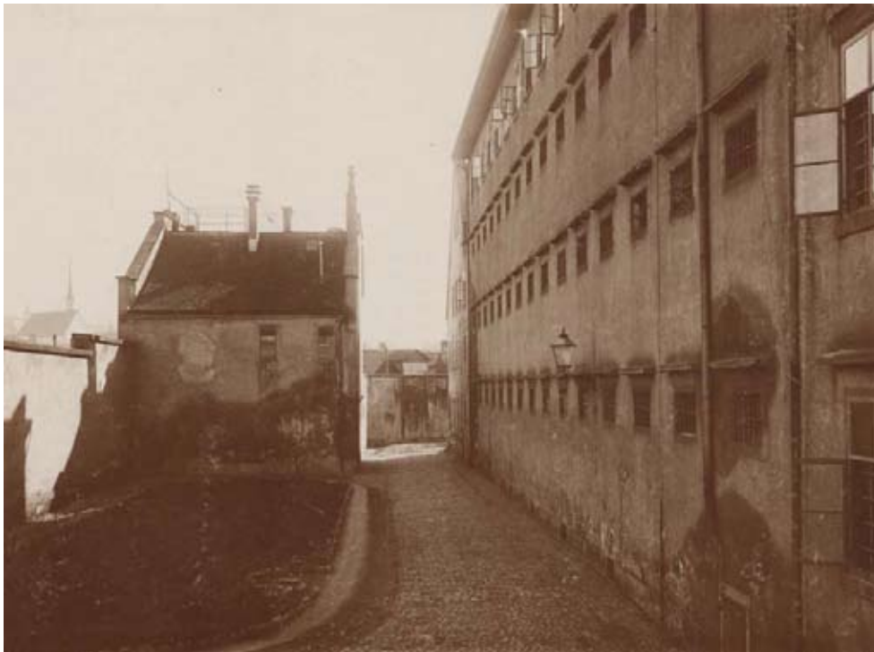
Der als Dienstwohnungshaus abgetrennte Nordteil des Ostflügels, ehemals Wohnung der Priorin. Rechts der Nordflügel der Strafanstalt. Foto 1900.
