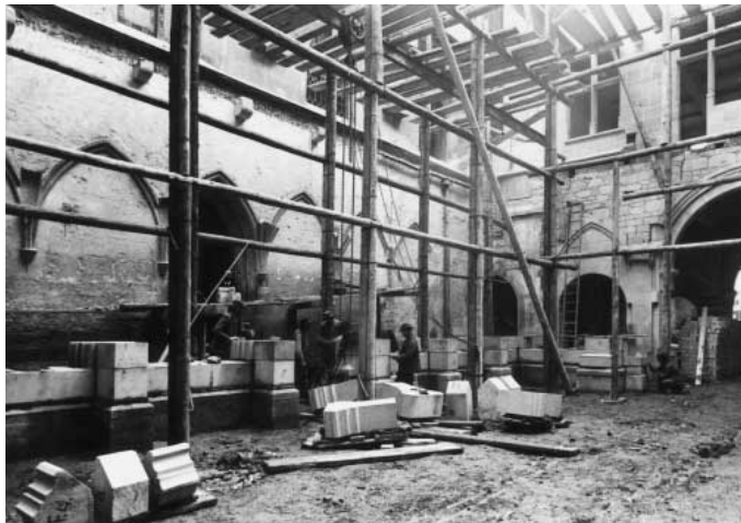
Bau des neuen Kreuzgangs. Südwand der Kirche.
