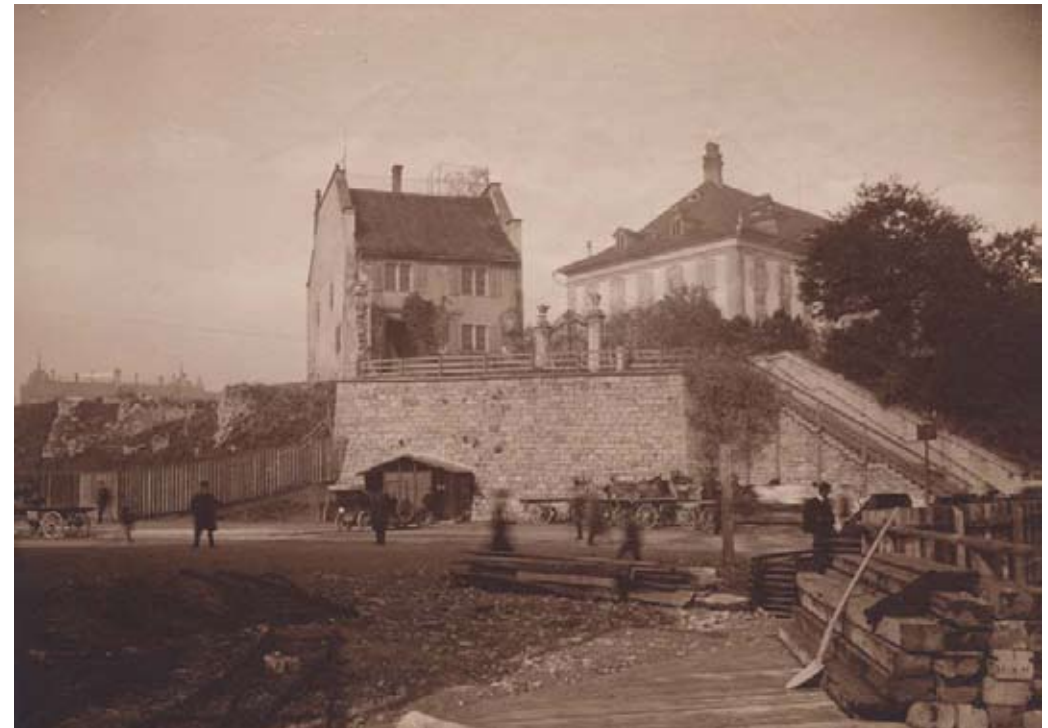
Das Dienstwohnungshaus kurz vor dem Abbruch. Rechts das Waisenhaus. Foto 31. Oktober 1911.
