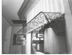
Historische Treppenanlage Ost (BAZ)
