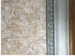
Historische Bauteile, Klosterzimmer
