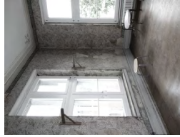
Klosterzimmer im DG wird erhalten
