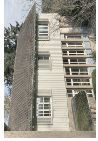
Annexbau mit zurückhaltend gestaltetem Geschoss (ehemals Abwahrnehmung) über dem repräsentativen Singsaal
