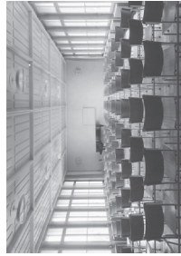
Sichtbare Tragstruktur mit abgehängter Grillage in der Pausenhalle
