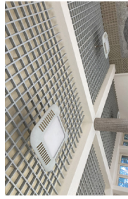
Sichtbare Tragstruktur mit abgehängter Grillage in der Pausenhalle
